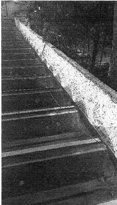
Remoção do revestimento da platibanda
