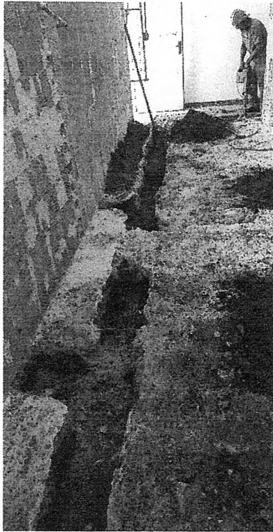
Escavação manual de valas
