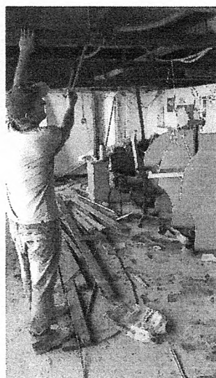
Retirada e elevação da Estrutura do forro de PVC
