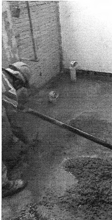
Fechamento de valas
